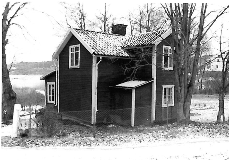
Boningshuset (nr.1) mot NO.
