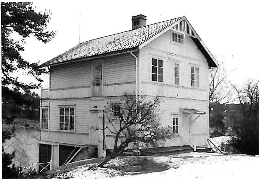
Boningshuset (nr.1) mot NO.
