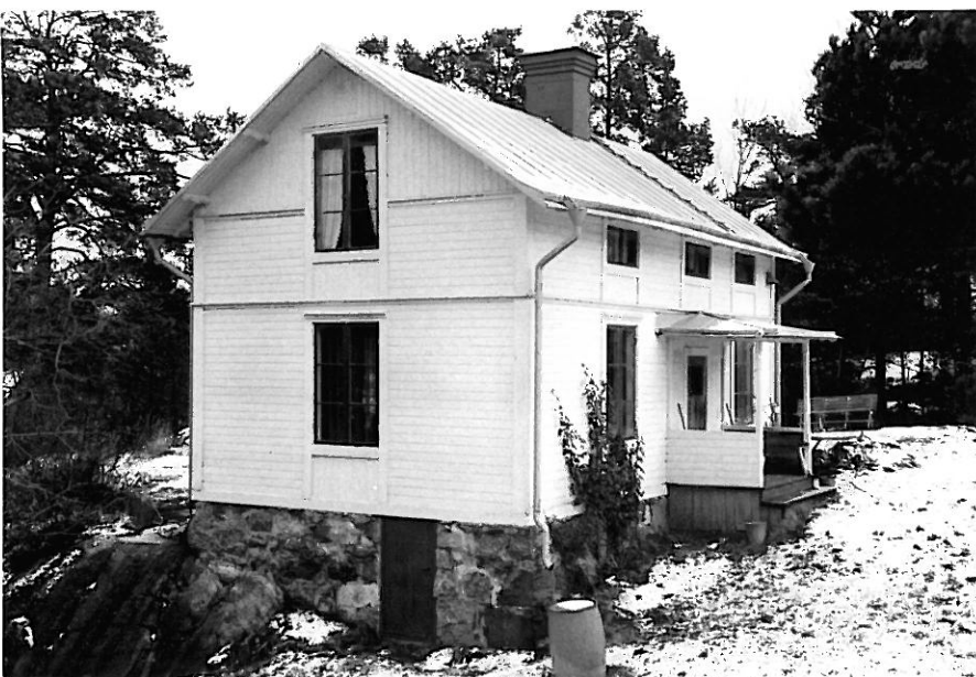
Boningshuset (nr.1) mot NO.
