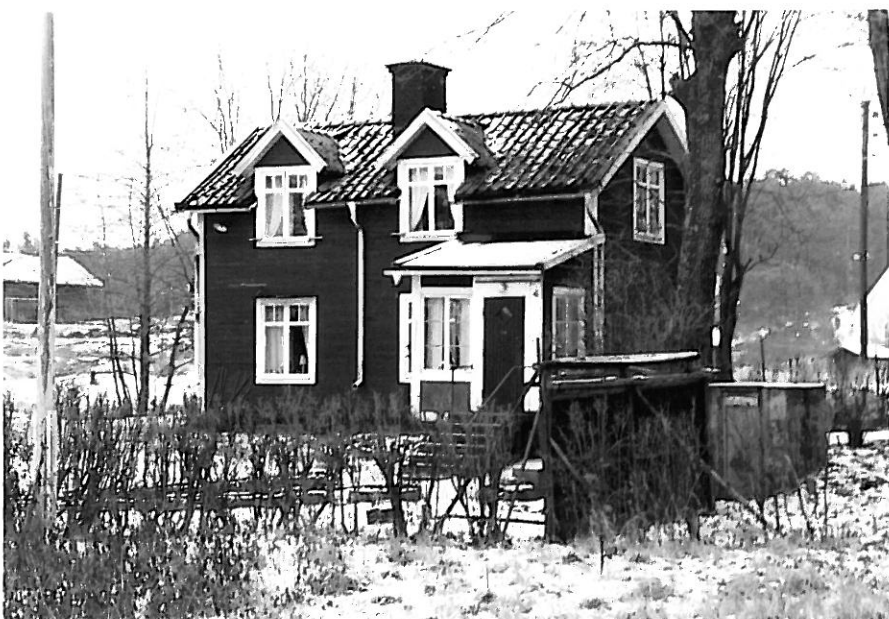
Boningshuset (nr.1) mot SO.
