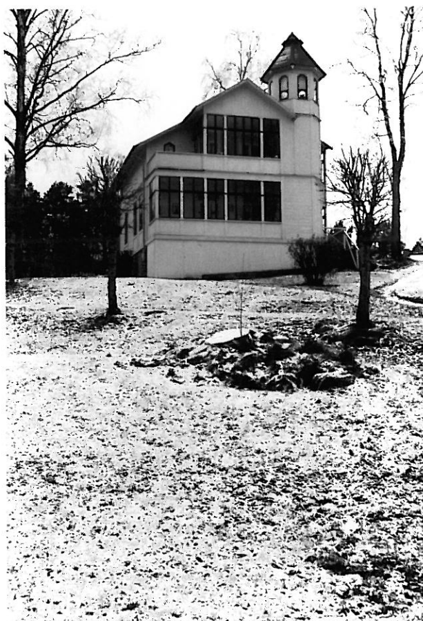
Boningshuset mot S.
