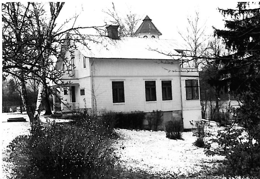
Boningshuset mot NV.
